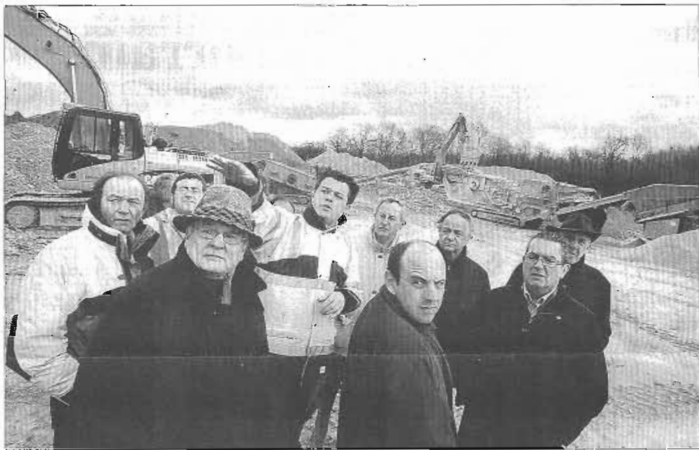
La réunion de chantier sur le site multifilières de Villers-la-Montagne a rassemblé responsables de la commission travaux du SMTOM et représentants d'entreprises.
