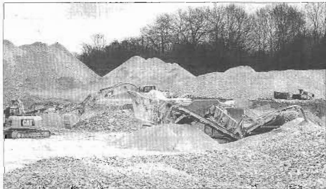
Le chantier avance rapidement. Le centre sera livré début 2010.
